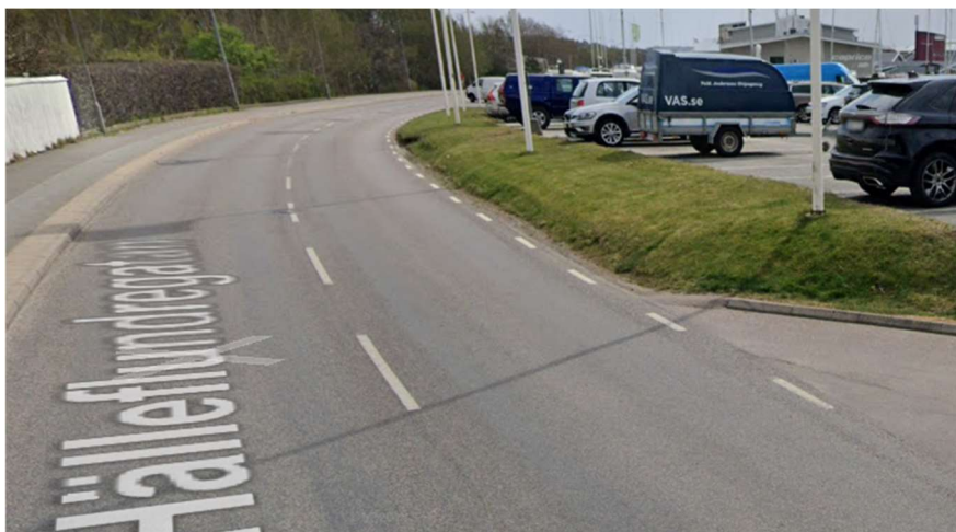
Figur 6. Dagvattenbrunnar saknas, dagvatten rinner in i gräsremsa (bild från Google maps).
