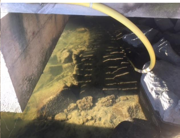
4. Befintlig konstruktion och sprängsten
